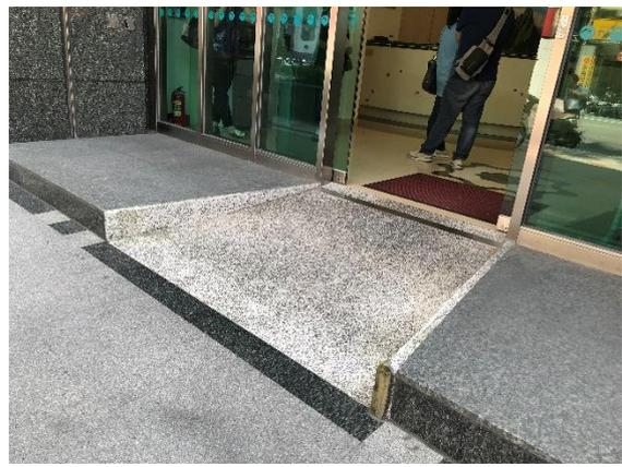
入口高差較小可採小斜坡方式處理參考圖
